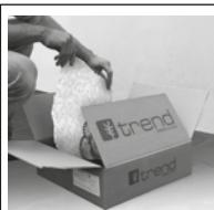
L'inizio di ogni fase di posa avviene con l'apertura delle confezioni imballate di mosaico. È opportuno verificare sempre lo stato dei singoli fogli contenuti nelle scatole, ed è buona norma mantenere il materiale da posare alla stessa temperatura dell'ambiente in cui si opera (limite di applicazione da +10°C a +35°C).
