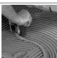
• *Una volta effettuata la tracciatura delle linee di posa, si stenda la colla. Il collante viene steso a (pavimento/revestimento) prestando cura che la dentatura della spatola sia idonea.*
