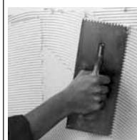
Una volta effettuata la tracciatura delle linee di posa, si stende la colla sul fondo dapprima con la parte liscia di una spatola dentata (dente quadrato da 4 x 4 mm) per garantire l'applicazione su tutta la superficie, in seguito si rimuova l'eccesso con la parte dentata avendo cura di mantenere una inclinazione della spatola ed una pressione adeguata affinché non resti sul fondo più del collante necessario.
