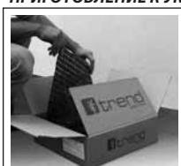
*L'inizio di ogni fase di posa avviene con l'apertura delle confezioni imballate di mosaico. È opportuno verificare sempre lo stato dei singoli fogli contenuti nelle scatole, ed è buona norma mantenere il materiale da posare alla stessa temperatura dell'ambiente in cui si opera (limite di applicazione da +10°C a +35°C).*
