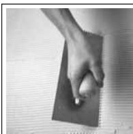
*Una volta effettuata la tracciatura delle linee di posa, si stende la colla sul fondo dapprima con la parte liscia di una spatola dentata (dente quadro da 4 x 4 mm) per garantire l'applicazione su tutta la superficie, in seguito si rimuova l'eccesso con la parte dentata avendo cura di mantenere una inclinazione della spatola ed una pressione adeguata affinché non resti sul fondo più del collante necessario.*
