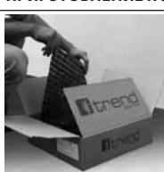
L'inizio di ogni fase di posa avviene con l'apertura delle confezioni imballate di mosaico. È opportuno verificare sempre lo stato dei singoli fogli contenuti nelle scatole, ed è buona norma mantenere il materiale da posare alla stessa temperatura dell'ambiente in cui si opera (limite di applicazione da +10°C a +35°C).
